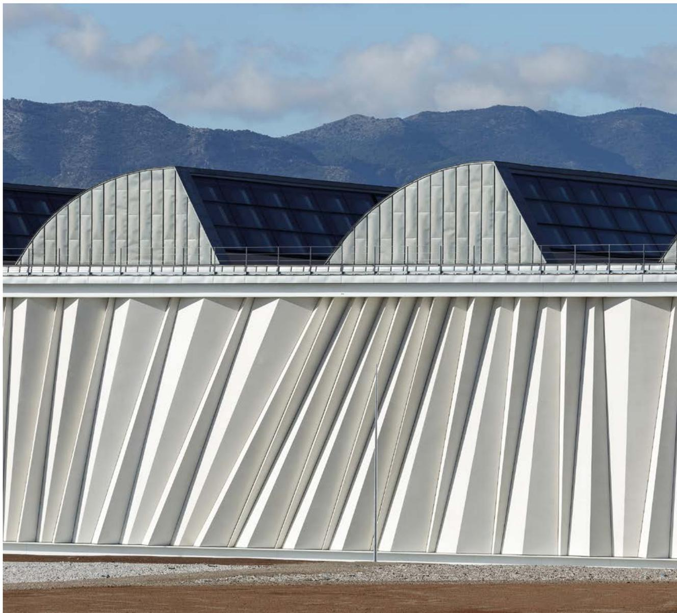
La envolvente de paneles blancos de GRC contrasta con el recubrimiento de chapa de zinc de los lucernarios de cubierta.
