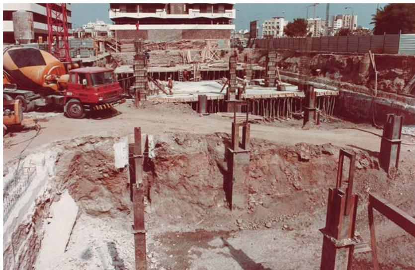
Soportes metálicos ejecutados en el terreno para comenzar la obra simultáneamente en sentido ascendente y descendente.
