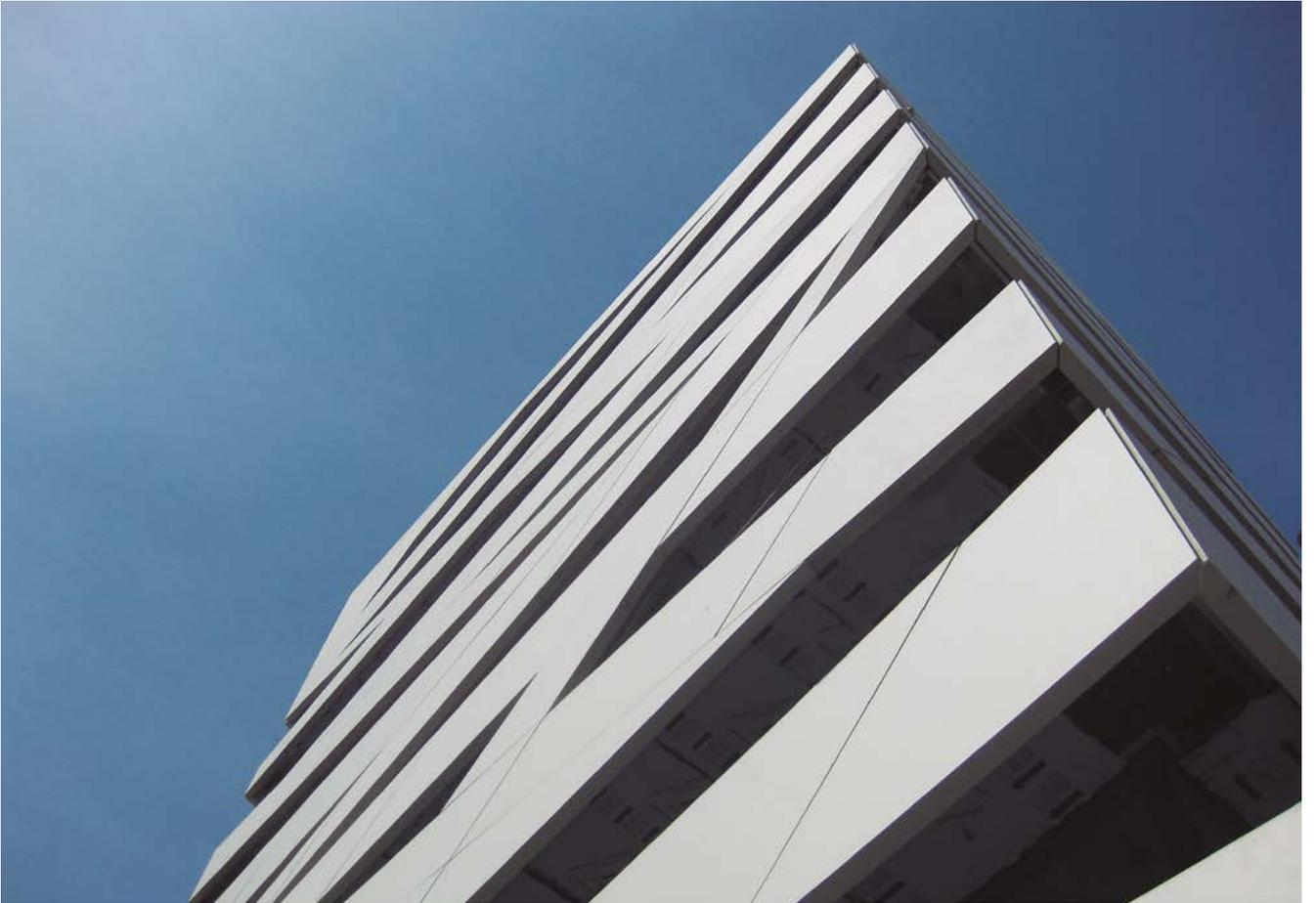
La envolvente de paneles de GRC funciona a modo de parasol.
